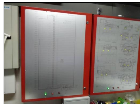
ง. แผงควบคุม (Fire Alarm Control Panel : FCP)
