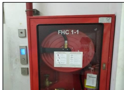
ข. ตู้เก็บสายฉีดน้ำดับเพลิงพร้อมอุปกรณ์
