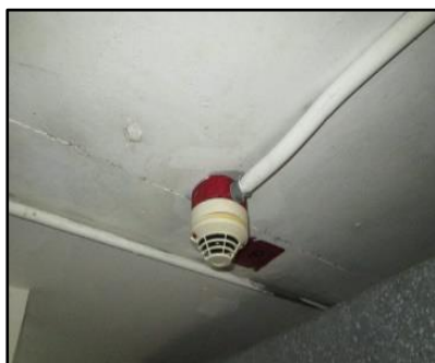
ค. เครื่องตรวจจับควัน (Smoke Detector)
